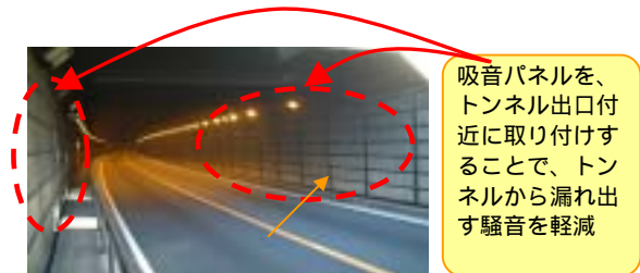
トンネル内の吸音処理
