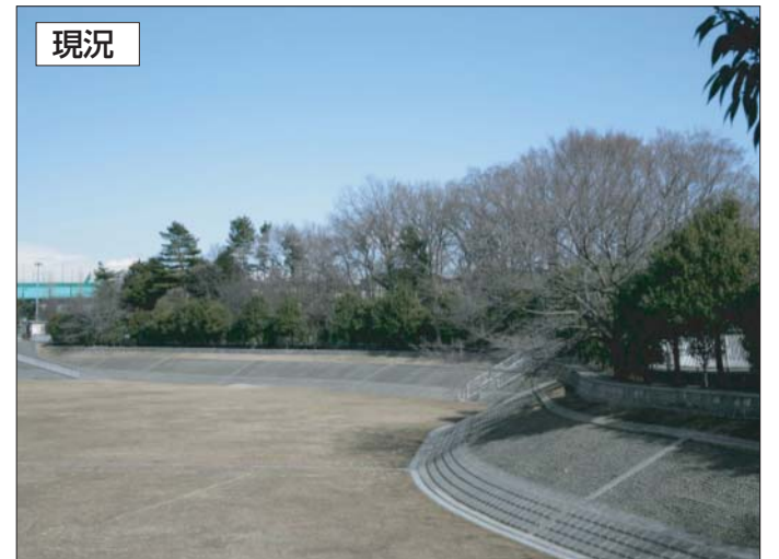
大泉JCT・目白通りIC周辺(白子川河岸段丘の緑地のある地区)
