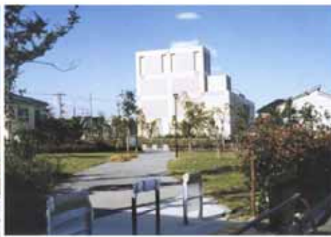
圏央道 青梅トンネル換気所緑地
