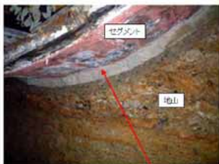
漏水防止の裏込め材
