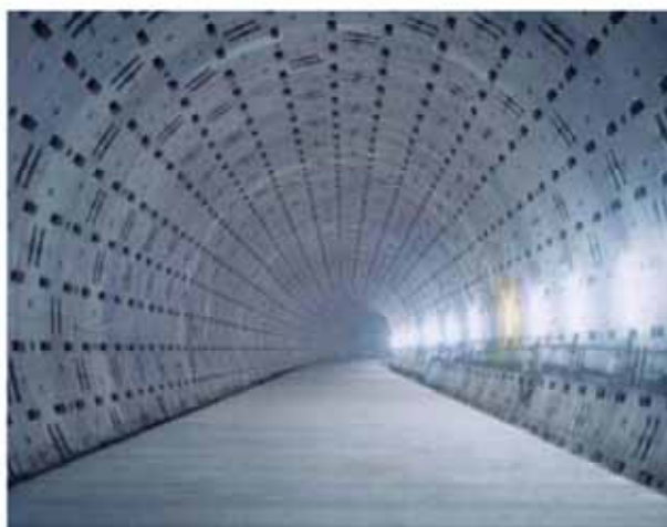
密閉型シールドトンネルの工事例
