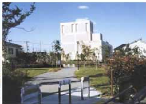
圏央道 青梅トンネル換気所緑地
