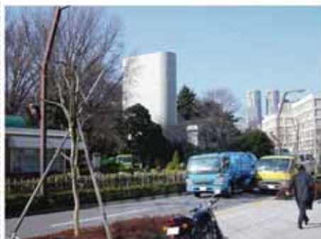
国道 20 号 新宿御苑換気所
