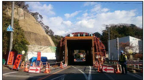
久保トンネル木更津側
