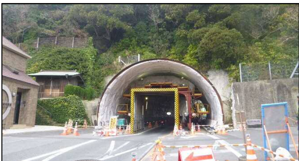
坂下トンネル館山側
