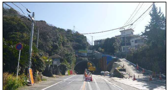
坂下トンネル木更津側
