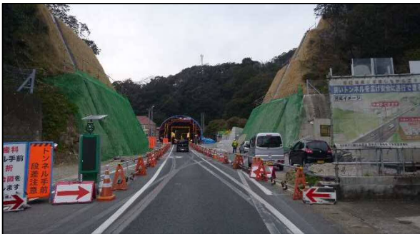
久保トンネル館山側
