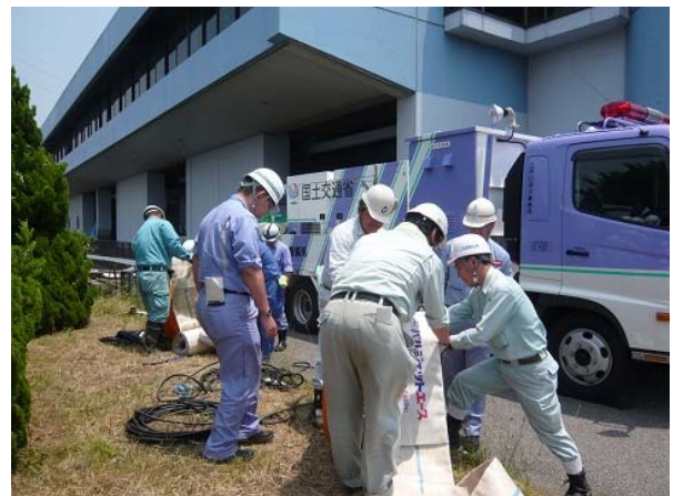
排水ポンプ車の講習（排水ホース組立中）
