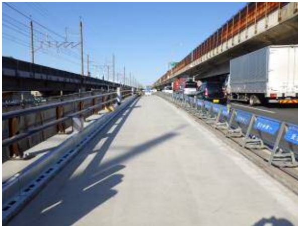
RC床版完了
