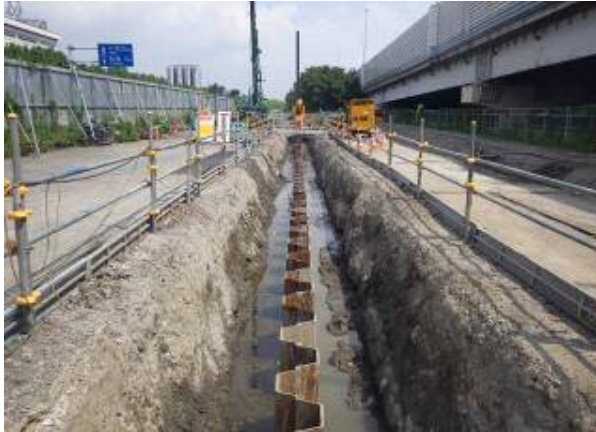
鋼矢板打設完了
