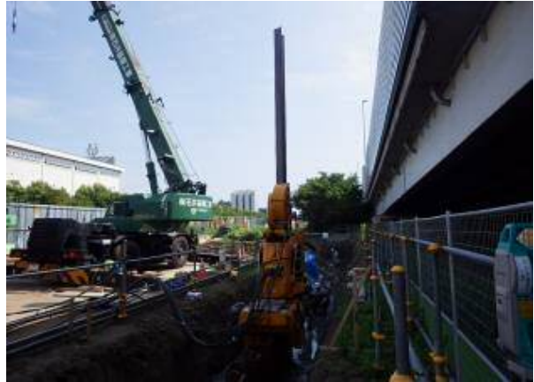
鋼矢板打設状況
