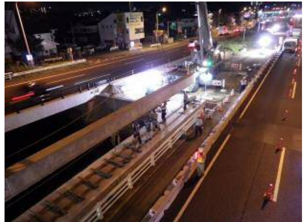
桁架設施工状況
