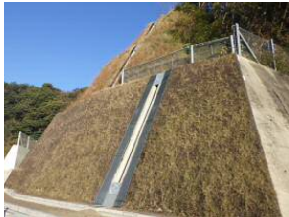
久保トンネル開削部法面 完成
