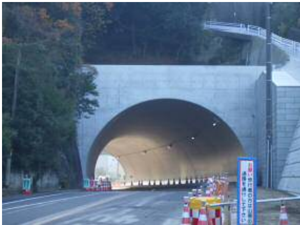
坂下トンネル終点側坑門工 完成
