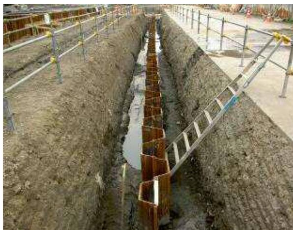
鋼矢板打設完了(市川共同溝)
