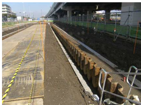
【完成】市川共同溝補強(鋼矢板打設)
