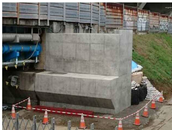
【完成】栄橋A2橋台(千葉側)
