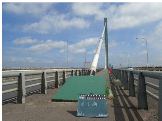
施工前(ケーブル補修)
