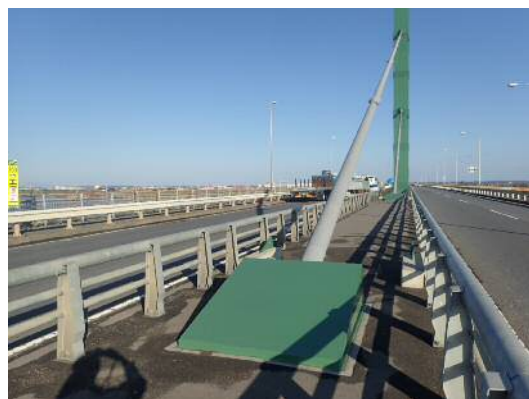
施工後(ケーブル補修)
