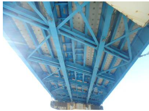
施工後(鋼板接着および炭素繊維シート貼り付け)
