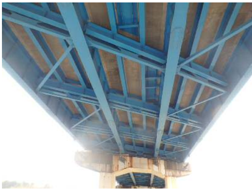
施工前(鋼板接着および炭素繊維シート貼り付け)
