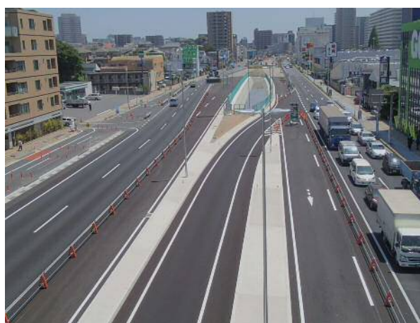
【完成】国道357号 千葉市中央区登戸4丁目地先 (東京方面から木更津方面を望む)
