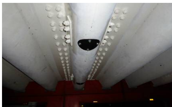
Uリブ当て板補強完了
