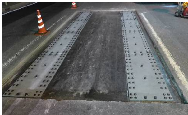
床版当て板補強完了状況
