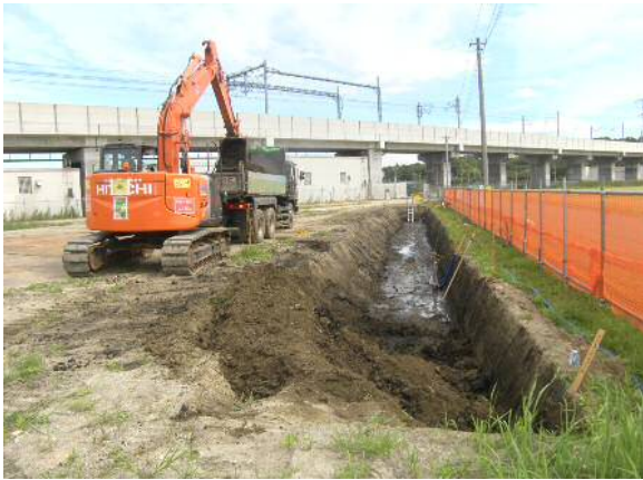
調整池内 ブロック積基礎掘削状況
