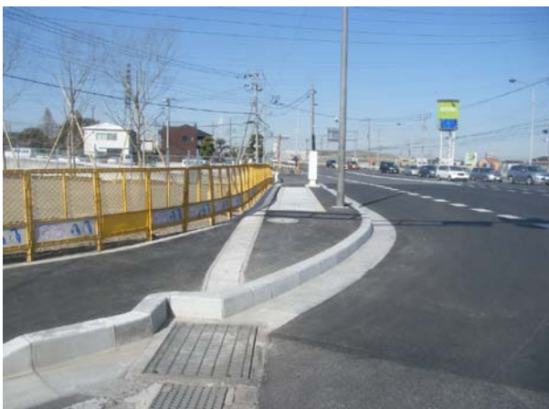
国道357号 千葉市中央区塩田町地先 (立坑換気口部完成状況)
