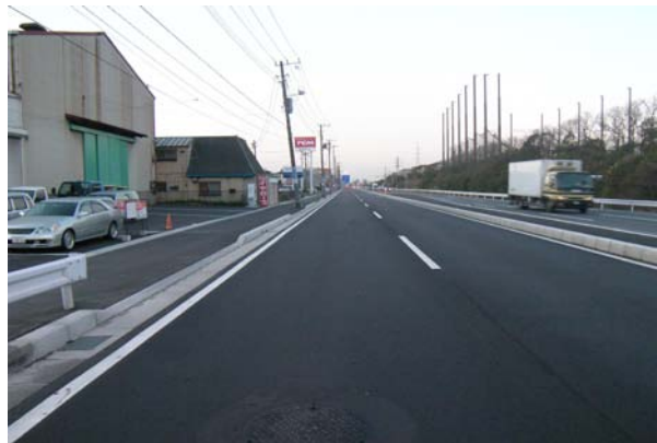
国道357号 千葉市中央区蘇我町地先 (工事終了点部から木更津方向を望む)
