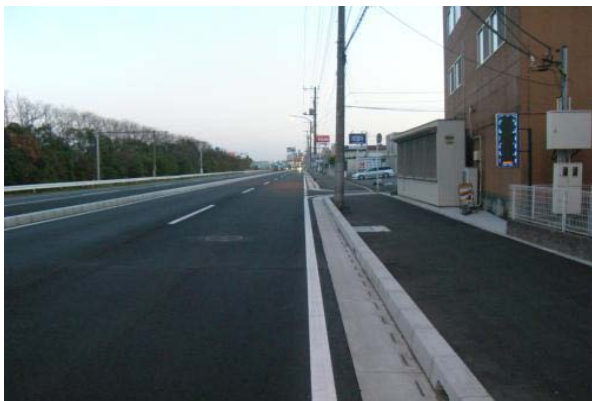
国道357号 千葉市中央区蘇我町地先 (工事起点部から東京方向を望む)
