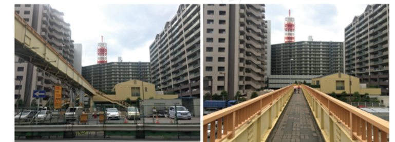
千葉銀行前歩道橋
