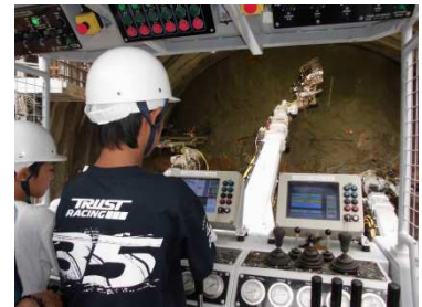
(三国トンネル:トンネル採掘体験)
