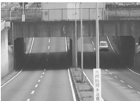
アンダーパス部 通常の状況
