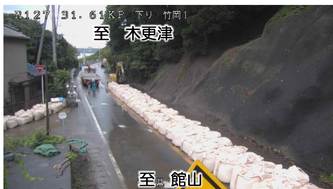
【土のう設置状況】
