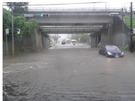
アンダーパス冠水時
