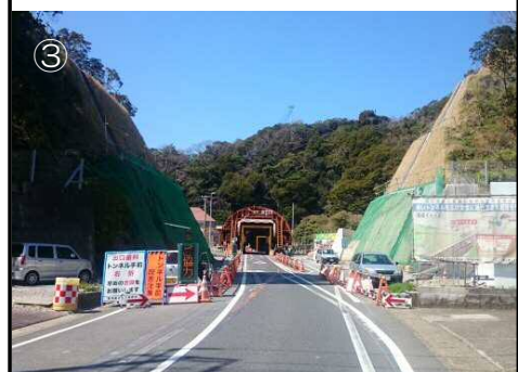
【平成28年3月 撮影】 館山方面から久保トンネルを望む
