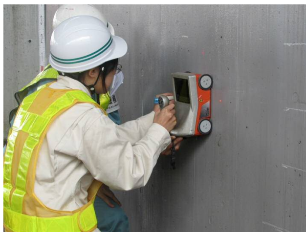
電磁レーダーによる橋脚の鉄筋探索の学習状況
