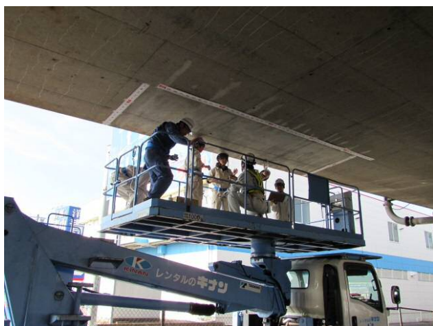
コンクリート上部工点検の学習状況
