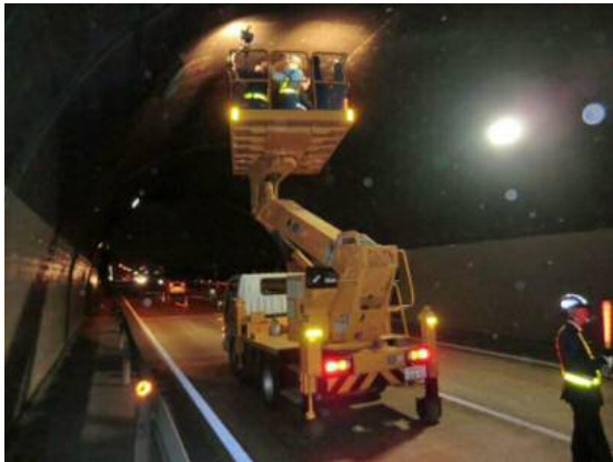
▲トンネル内部点検例
