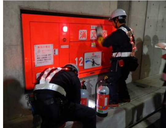
▲附属物(消火栓)点検例
