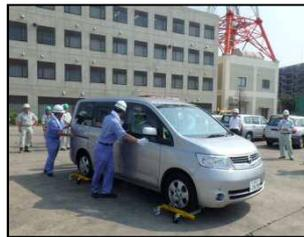
道路啓開時には、レッカー車や左の写真の車両移動器具を使用し、車両を移動します。
