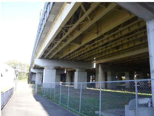
一般国道16号 今井高架橋
