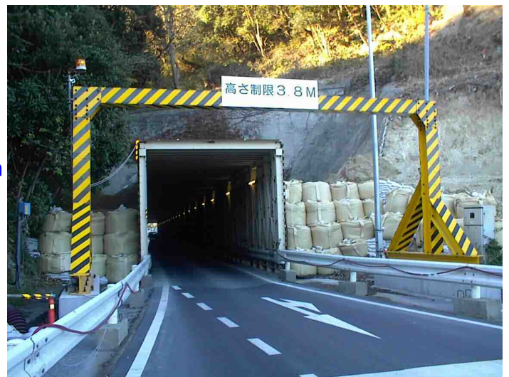
図-3 車両防護イメージ(平成14年度) (国道127号勝岩トンネル拡幅工事)
