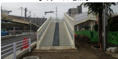
新つくし野歩道橋 (②)
