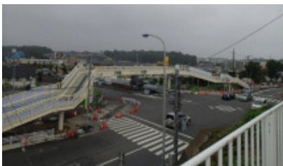
新つくし野歩道橋 (①)
