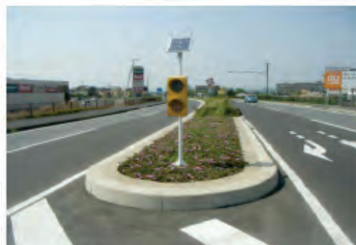
植栽実施箇所
