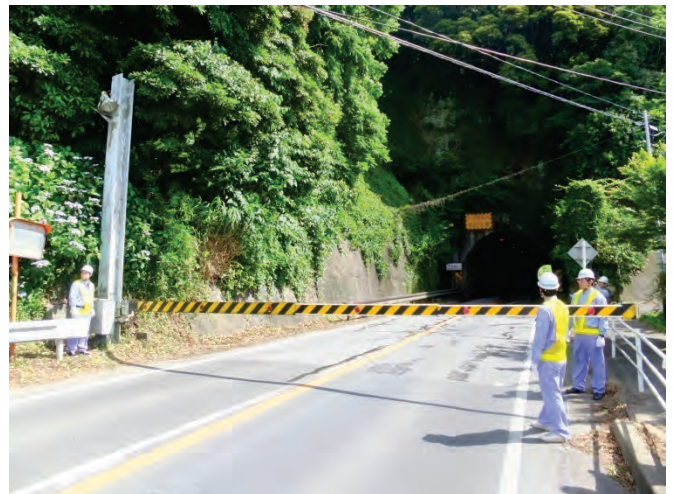
（遮断機の操作点検の様子）
