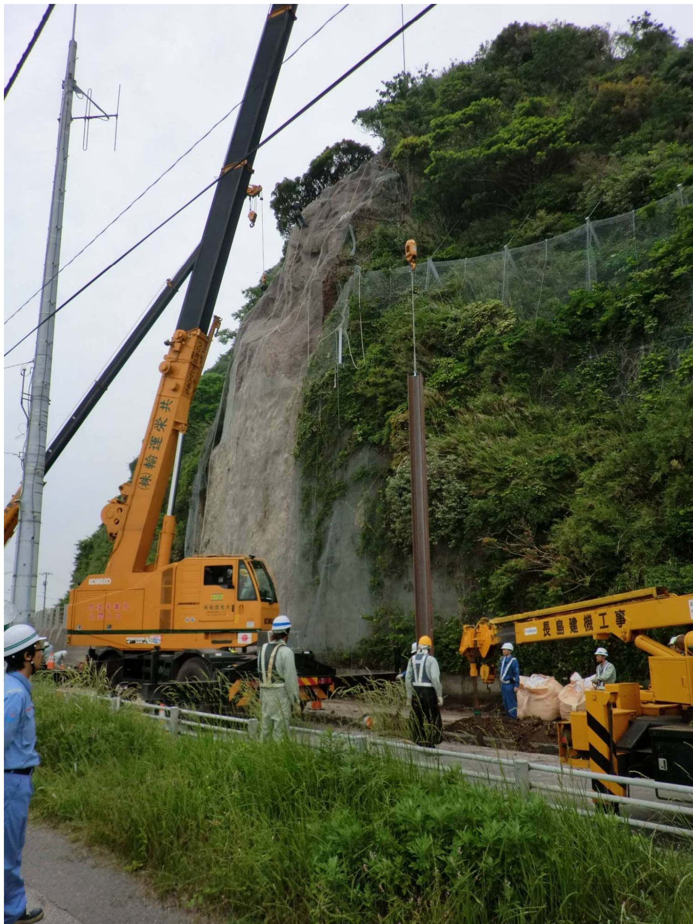
仮設防護柵の設置状況
