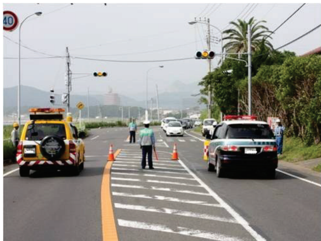
(通行止めの様子)
