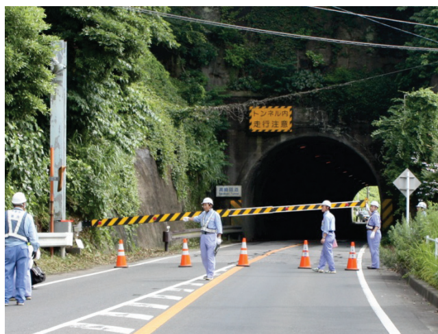
(遮断機の操作点検の様子)
