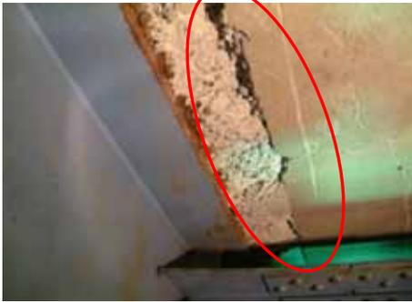
橋軸方向にひび割れが確認されました。放置すると損傷拡大が懸念されます。
