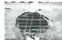
ひび割れの損傷がさらに進行すると陥没が発生し
