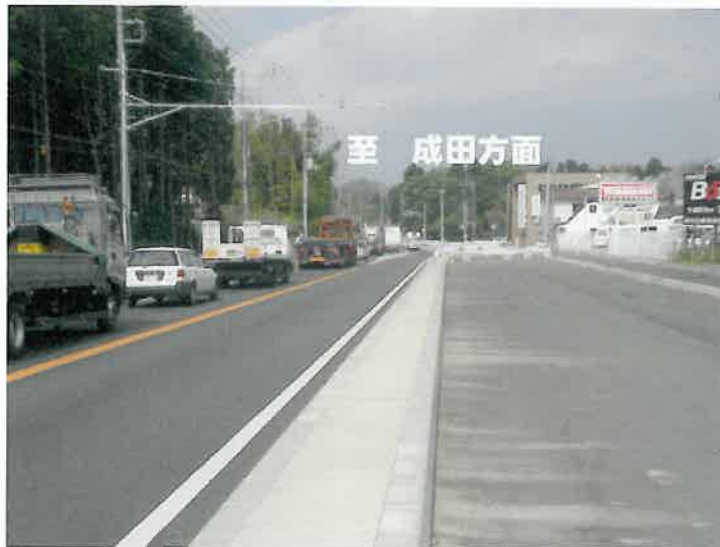
《国道51号千葉市若葉区若松町（北千葉拡幅）》
