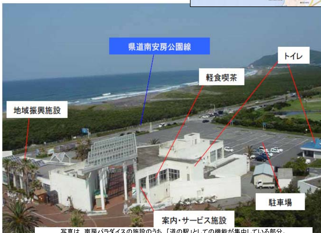
写真は、南房パラダイスの施設のうち、「道の駅」としての機能が集中している部分。
