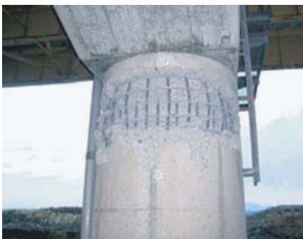
国道8号新組跨線橋
