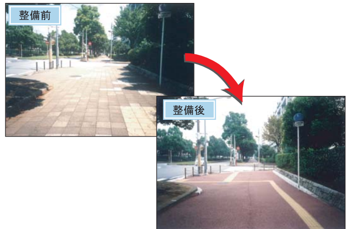
バリアフリー化された歩道(磯辺畑町線:千葉市美浜区)
