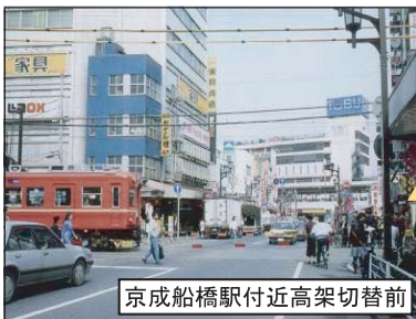
船橋第1号踏切：都計道3・4・10号線
