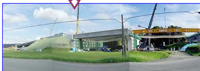
根岸橋上部の架設風景
