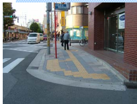
バリアフリー化された歩道
