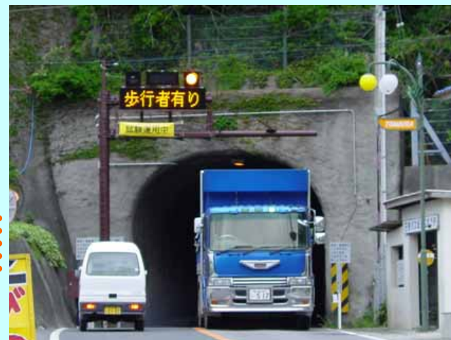
一般国道127号:南房総市 坂下トンネル
